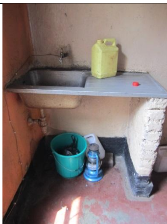
CTO – Point d'eau 4
