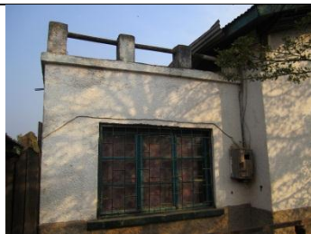
CTO – Toit où installer le tank
